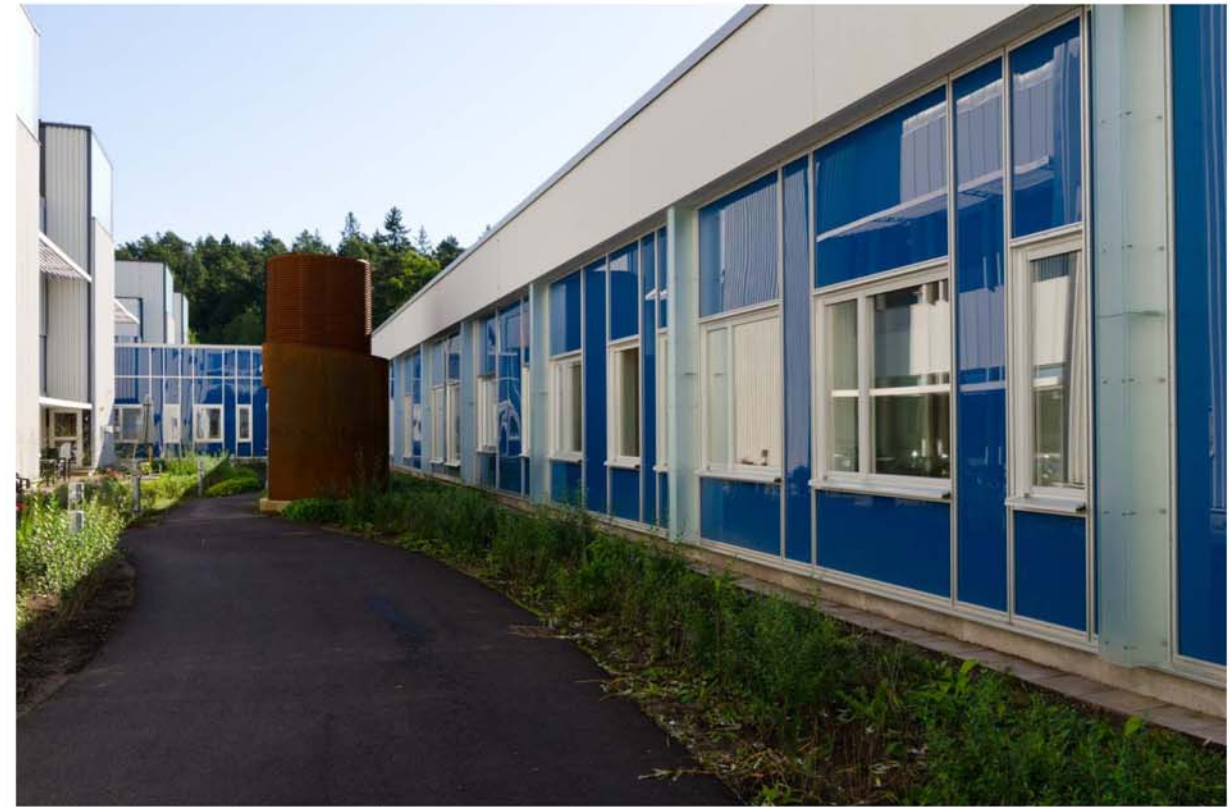
Baksida mot radiologen. Fläkt- och utrymningstorn av corten.
