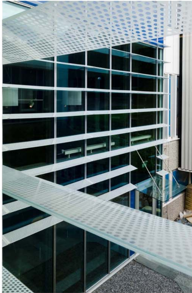
Screentryckta glaslameller som solavskärmning.
